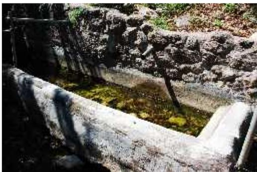
Fig. 11 – i fontanili montani in cemento con pareti lisce risultano poco idonei per gli anfibi, loc. vallone del Rio **(foto Amilcare D’Orsi)**
